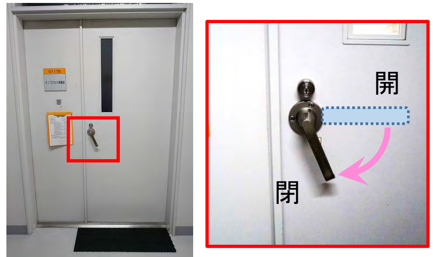
図2. クリーンルーム前室入口
